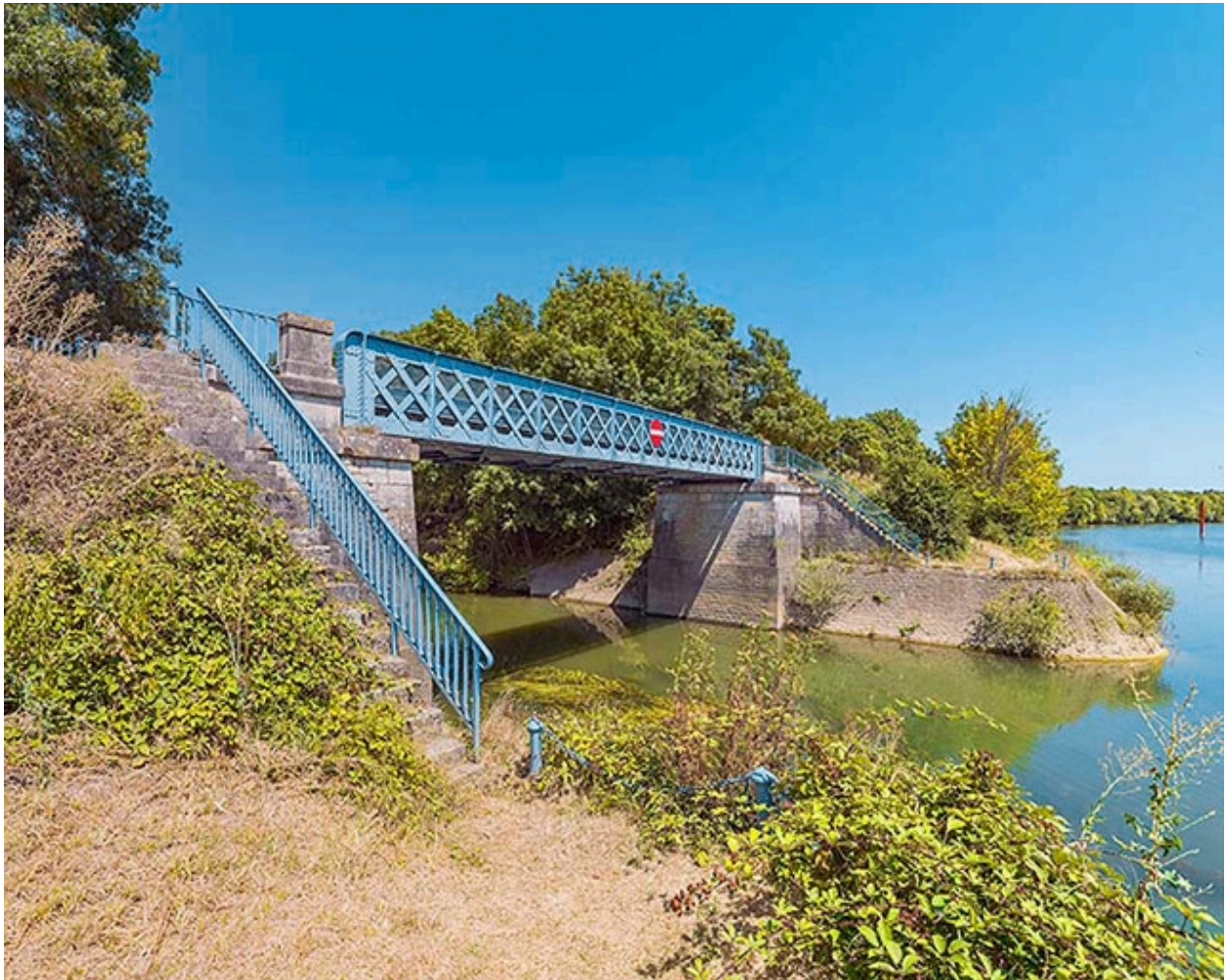
Vue d'ensemble du pont sur la Dheune.
