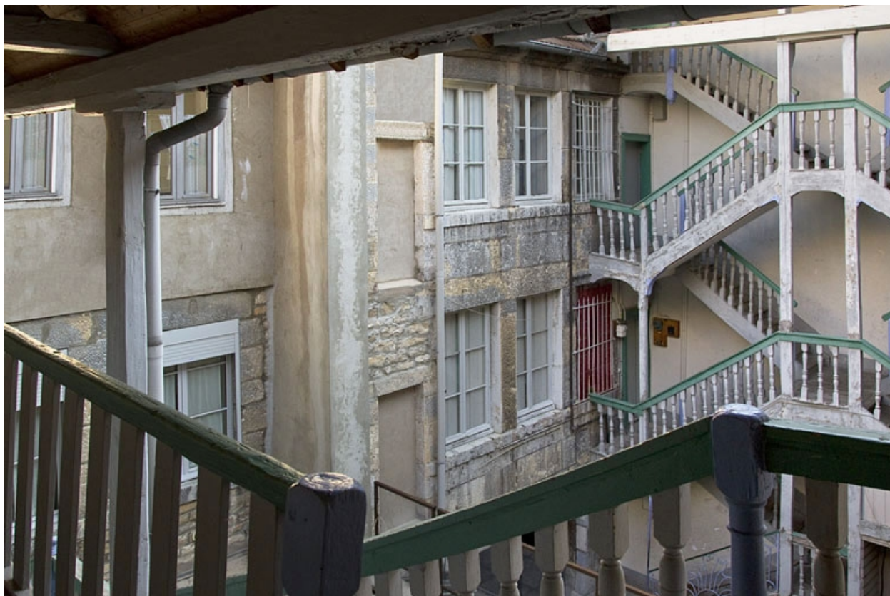
Vue de la première cour.
