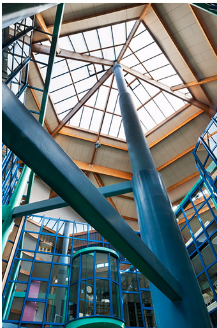
Intérieur et verrière de l'atrium.
