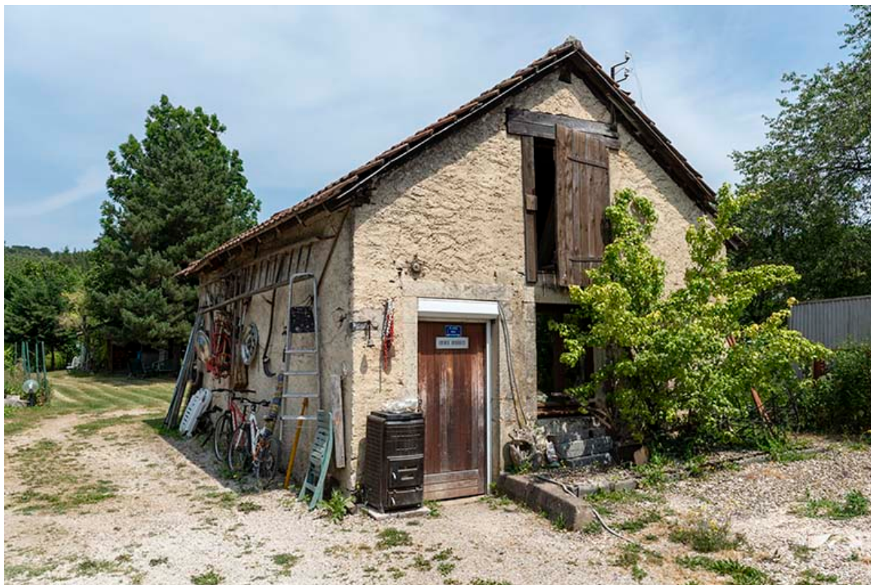
Forge : façade antérieure, de trois quarts gauche.
