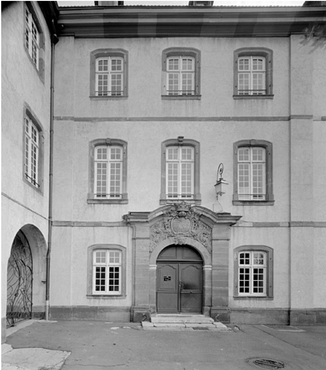
Corps de bâtiment principal. Partie gauche de la façade sur cour.
