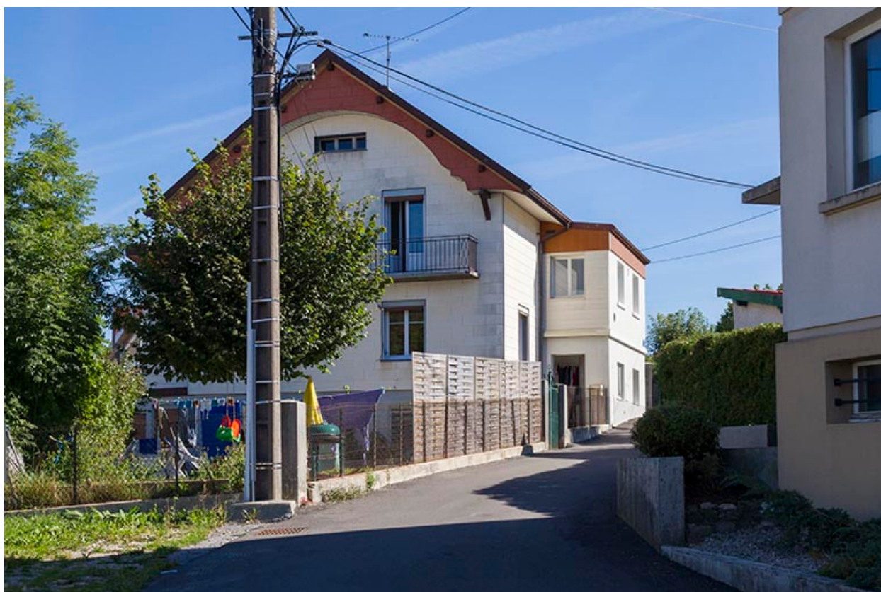
Maison : élévation ouest.
