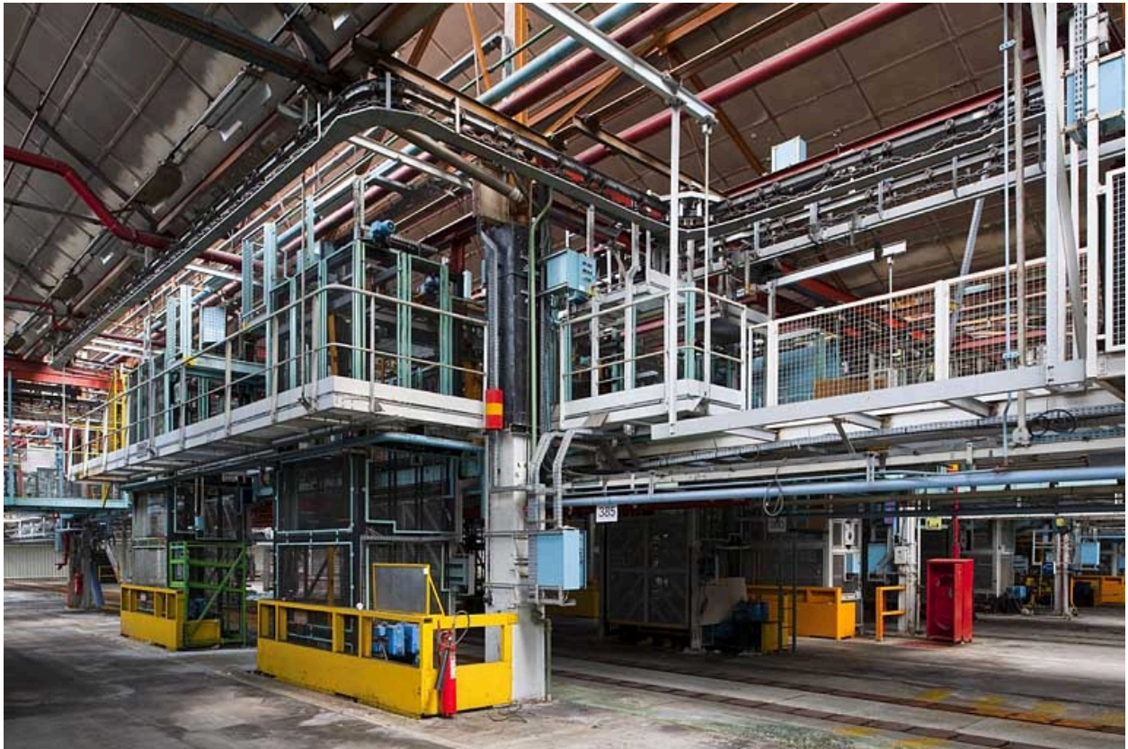
Atelier de montage désaffecté (4).
