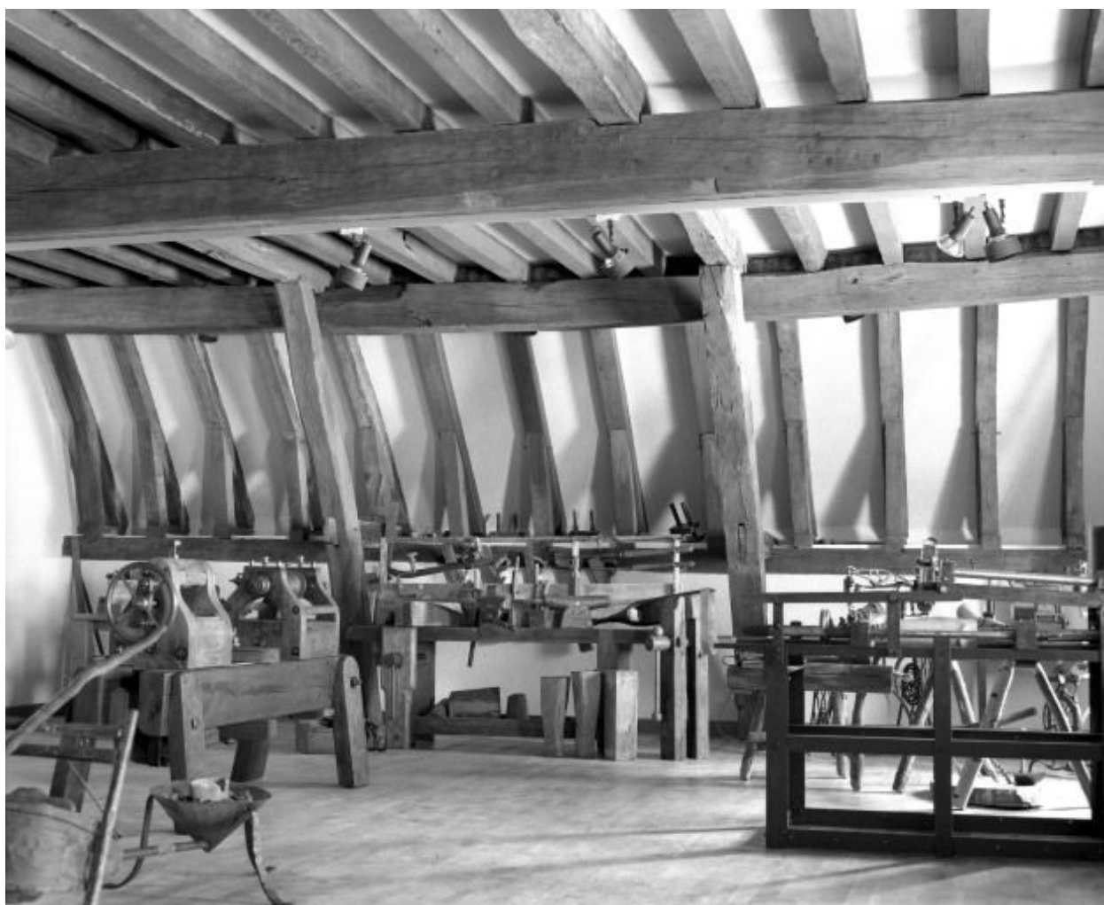
Charpente du niveau inférieur du comble.
