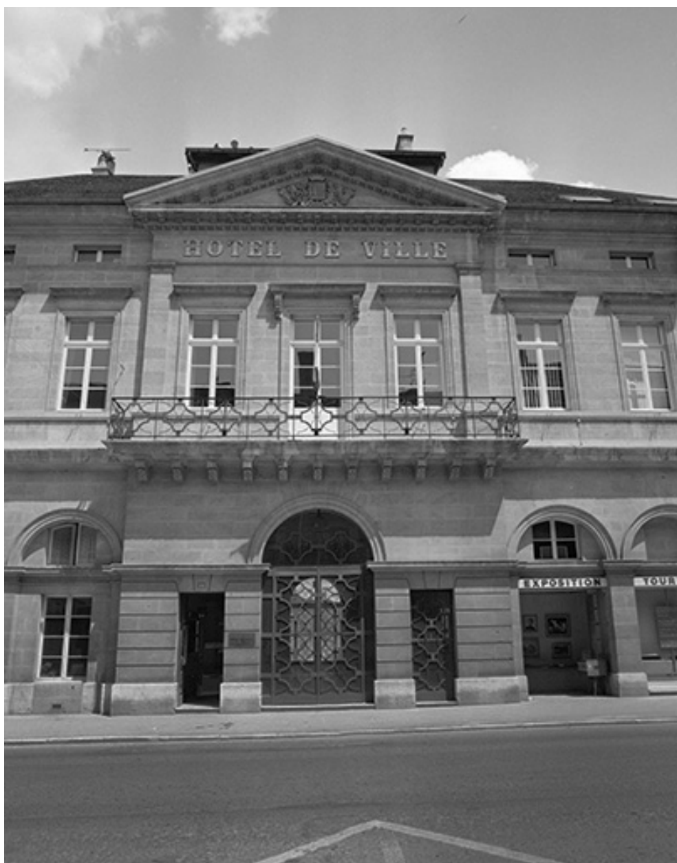
Façade antérieure, partie centrale.
