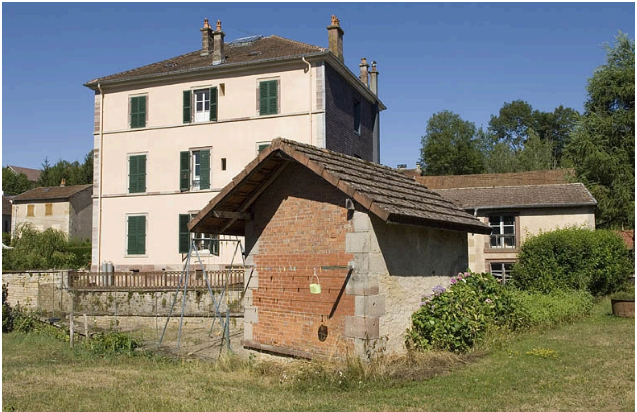
Logement patronal sud. Façade postérieure.
