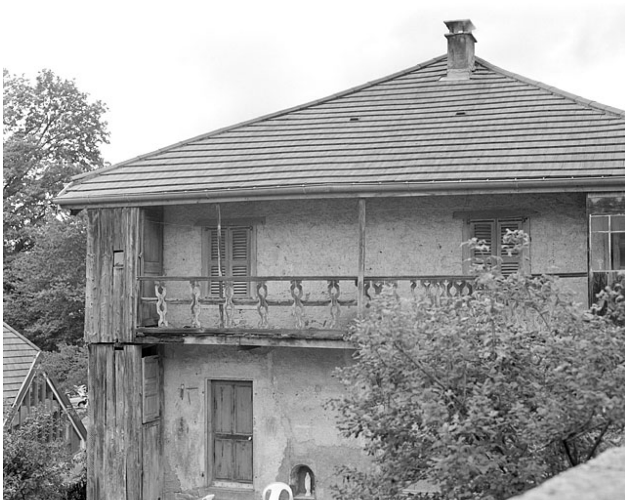
Balcon en galerie sur la façade antérieure.
