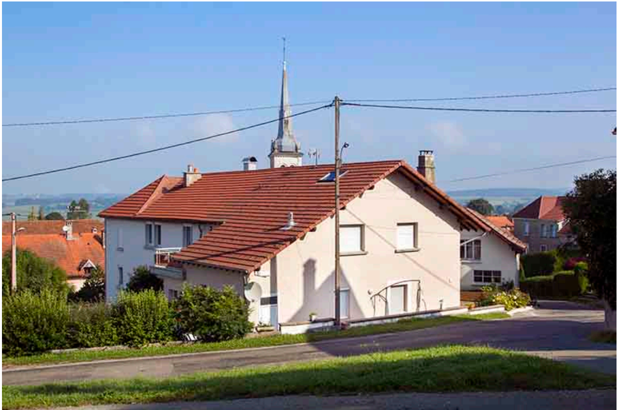
Façades postérieure et latérale droite.
