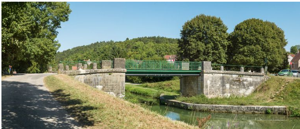
Vue d'amont du pont.
