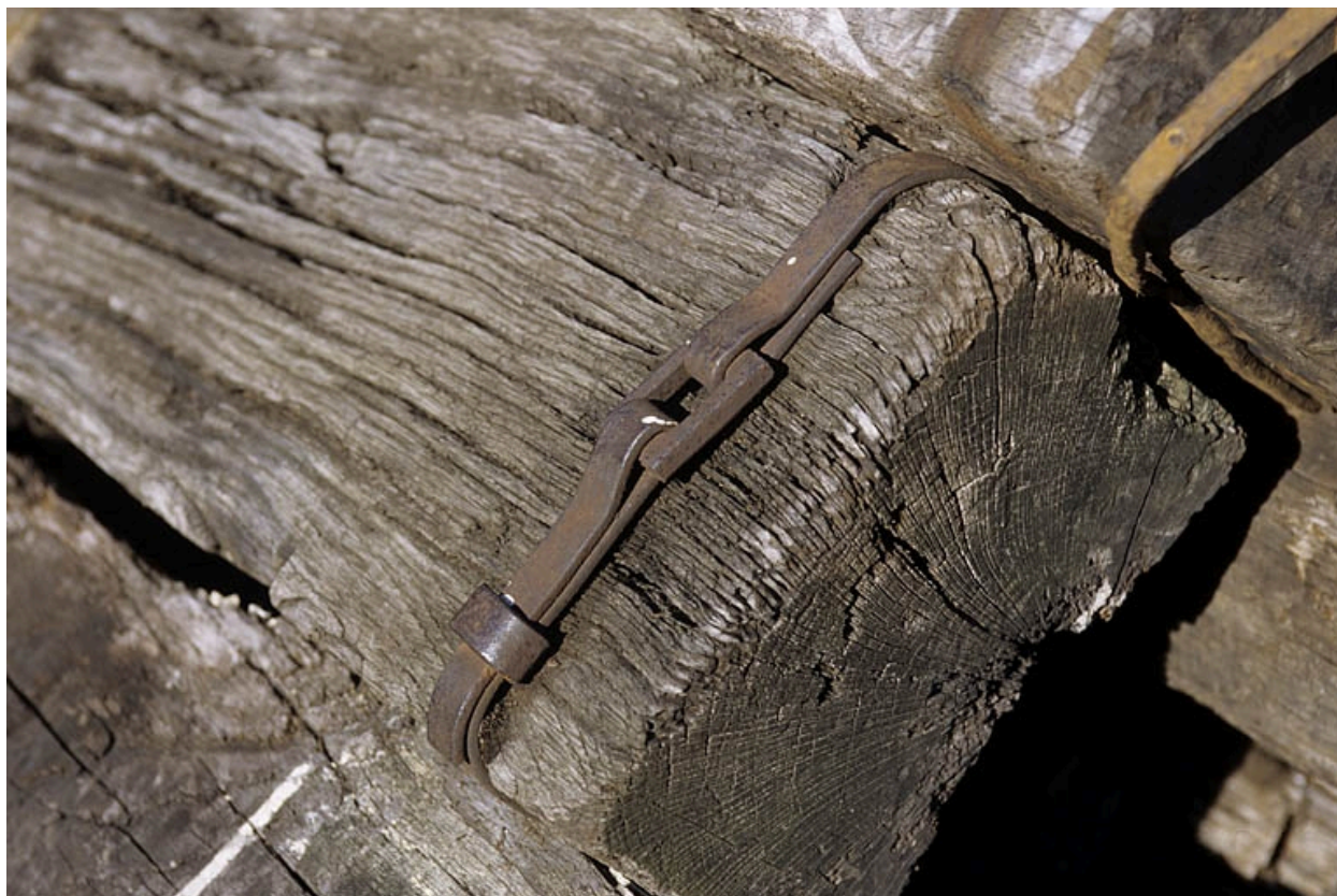
Extrémité d'une traverse avec frettage Delor.
