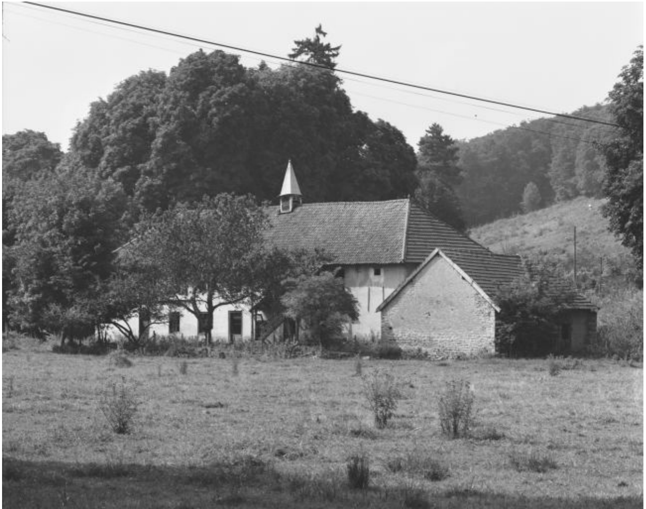
Façade postérieure du presbytère.
