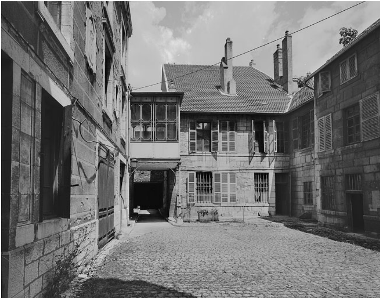
Vue d'ensemble depuis le fond de la cour.
