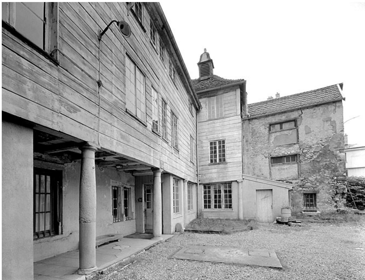
Façade sur cour et pavillon d'escalier.
