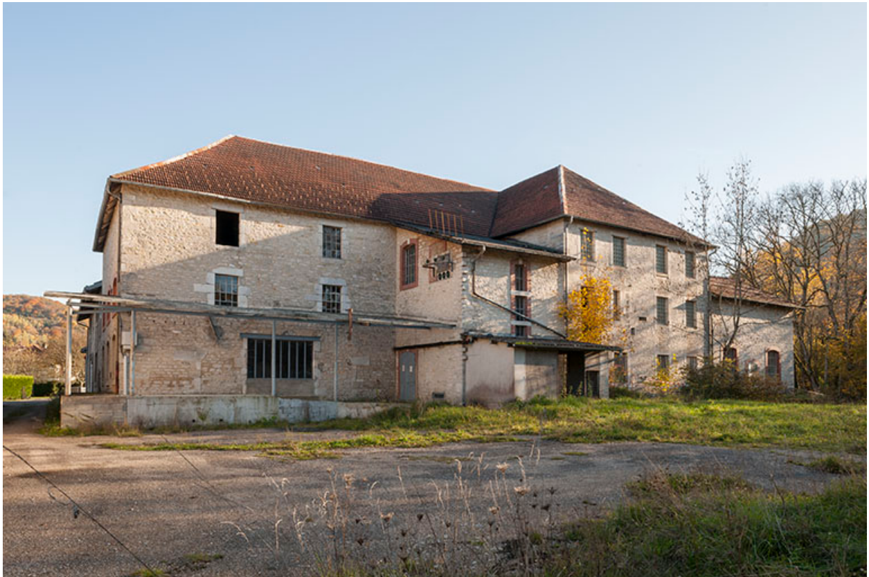
Atelier de fabrication vu depuis le nord.
