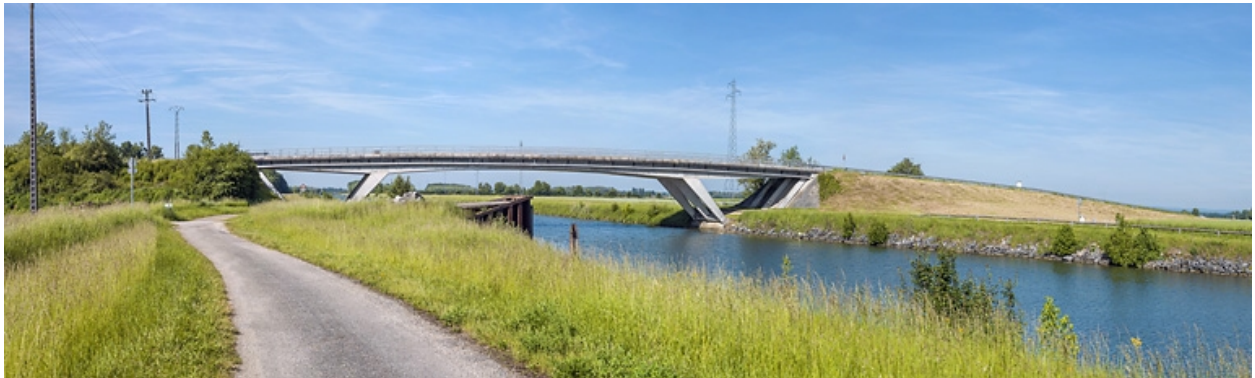
Vue d'ensemble d'amont, rive gauche.
