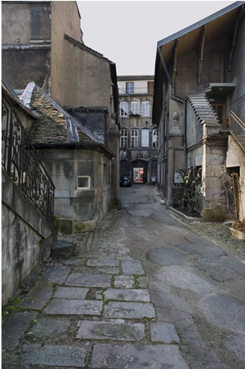
Vue d'ensemble de l'édifice depuis le fond de la parcelle.
