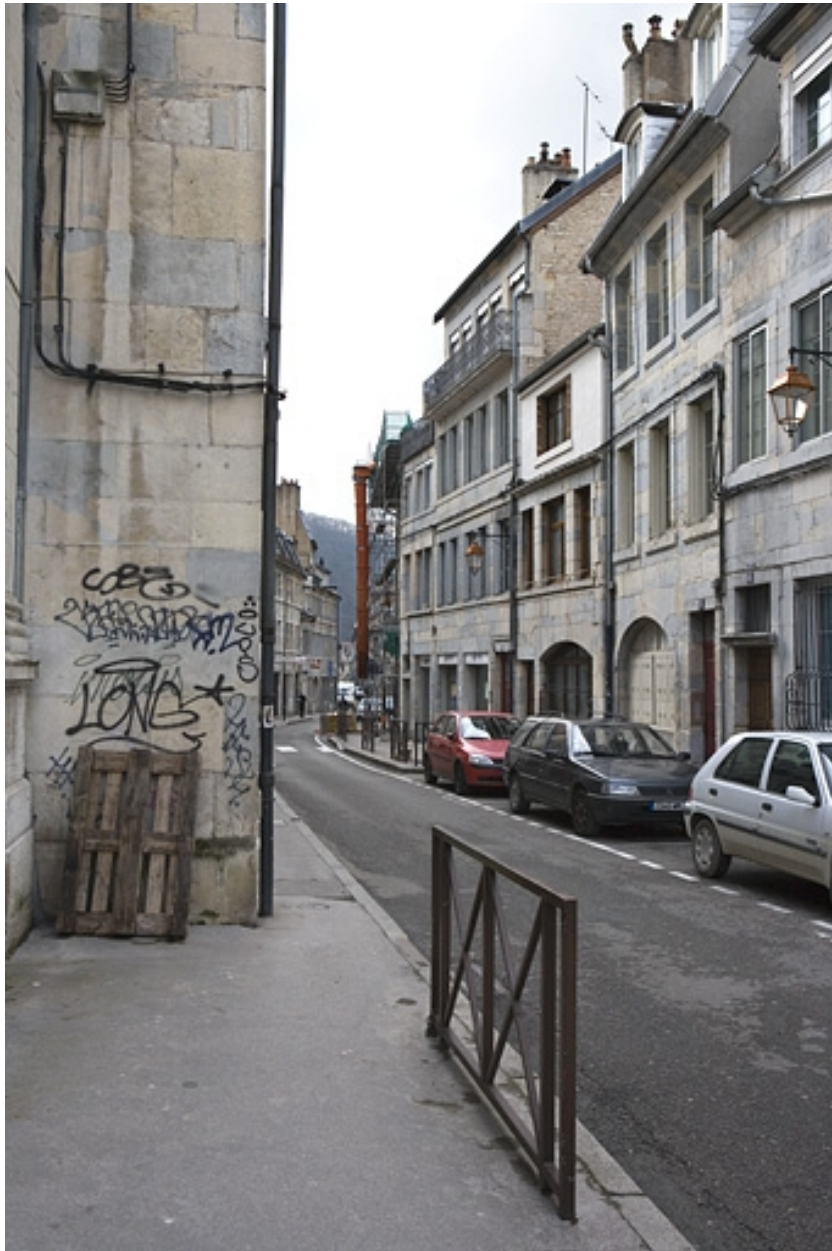
Vue d'ensemble de la façade principale dans l'alignement de la rue.
