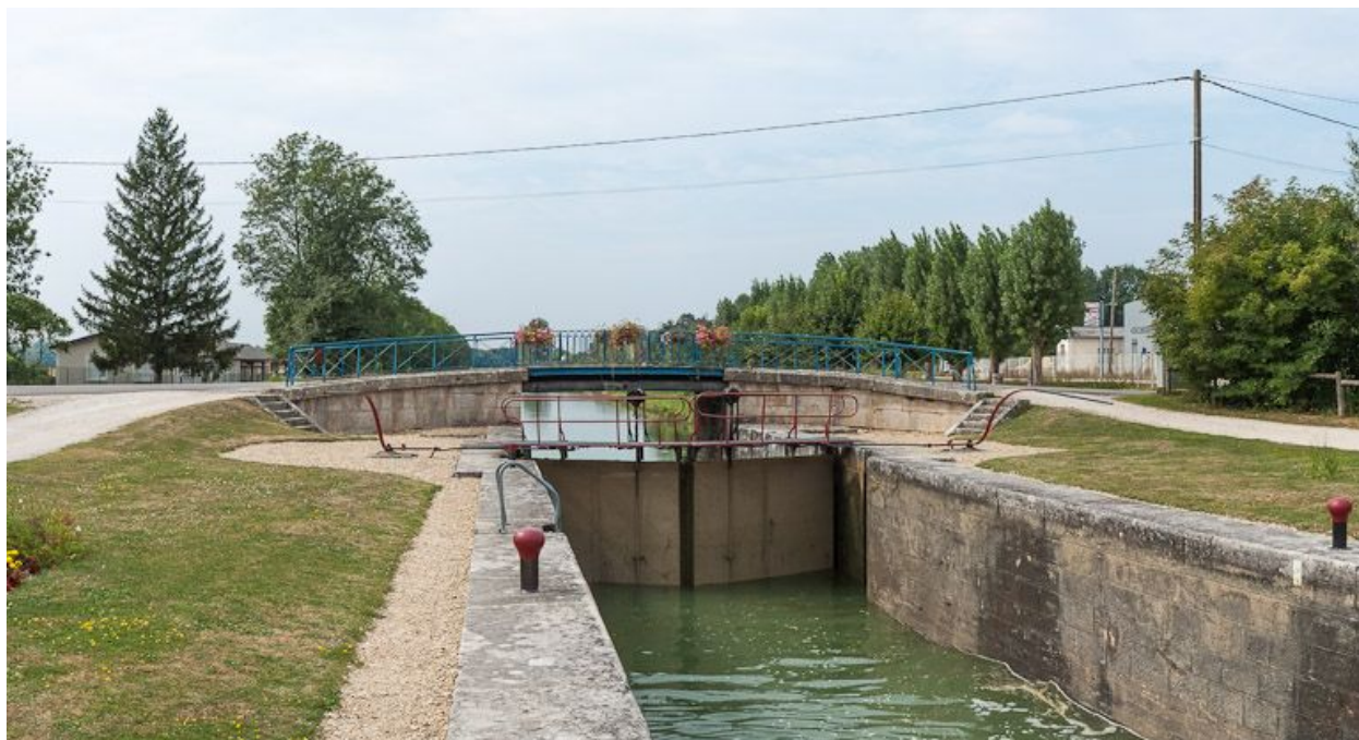
Vue du pont depuis le sas.
