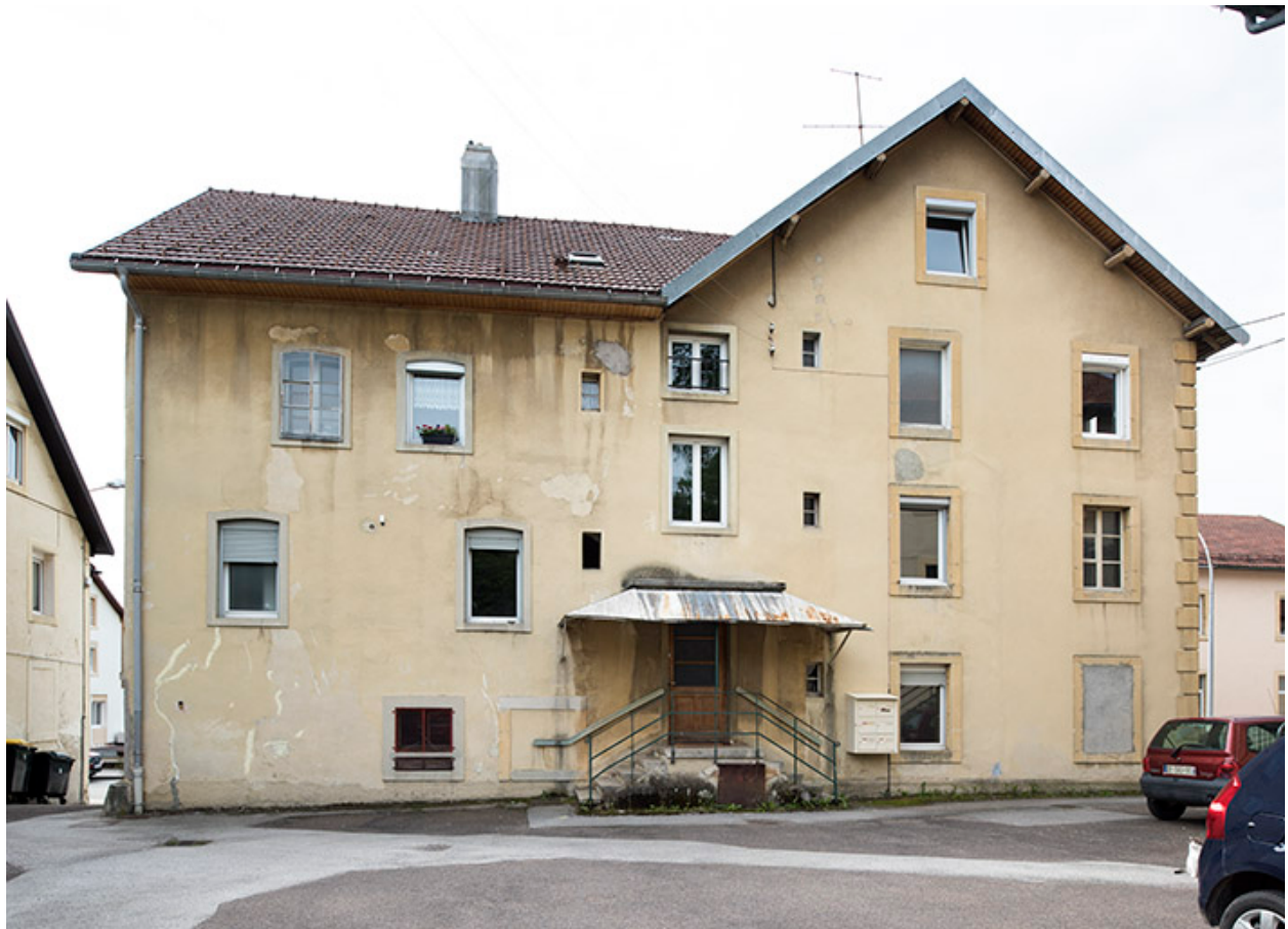
Bâtiment sur rue : façade postérieure.
