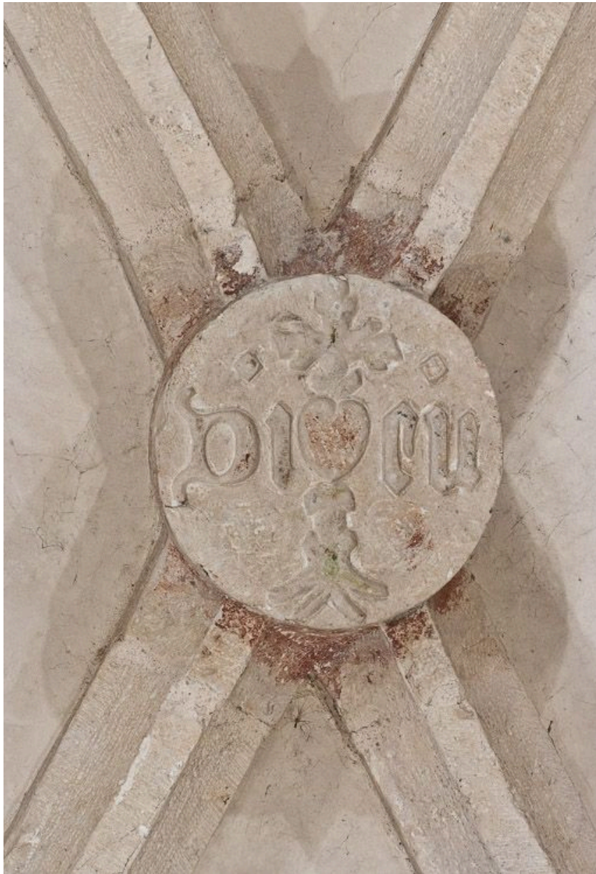
Clef de voûte de la deuxième travée du bas-côté droit.
