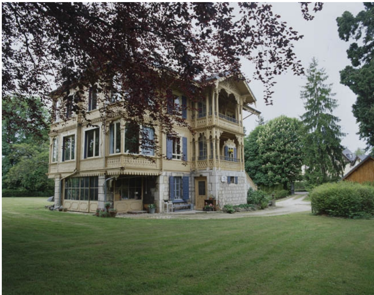
Chalet. Vue d'ensemble depuis le nord-est.
