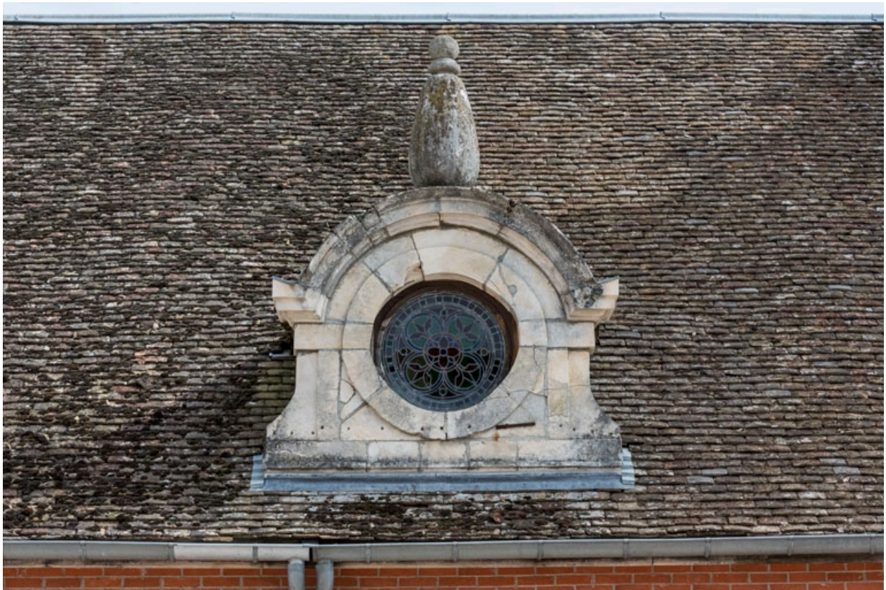
Elévation antérieure : oeil-de-boeuf du corps central.
