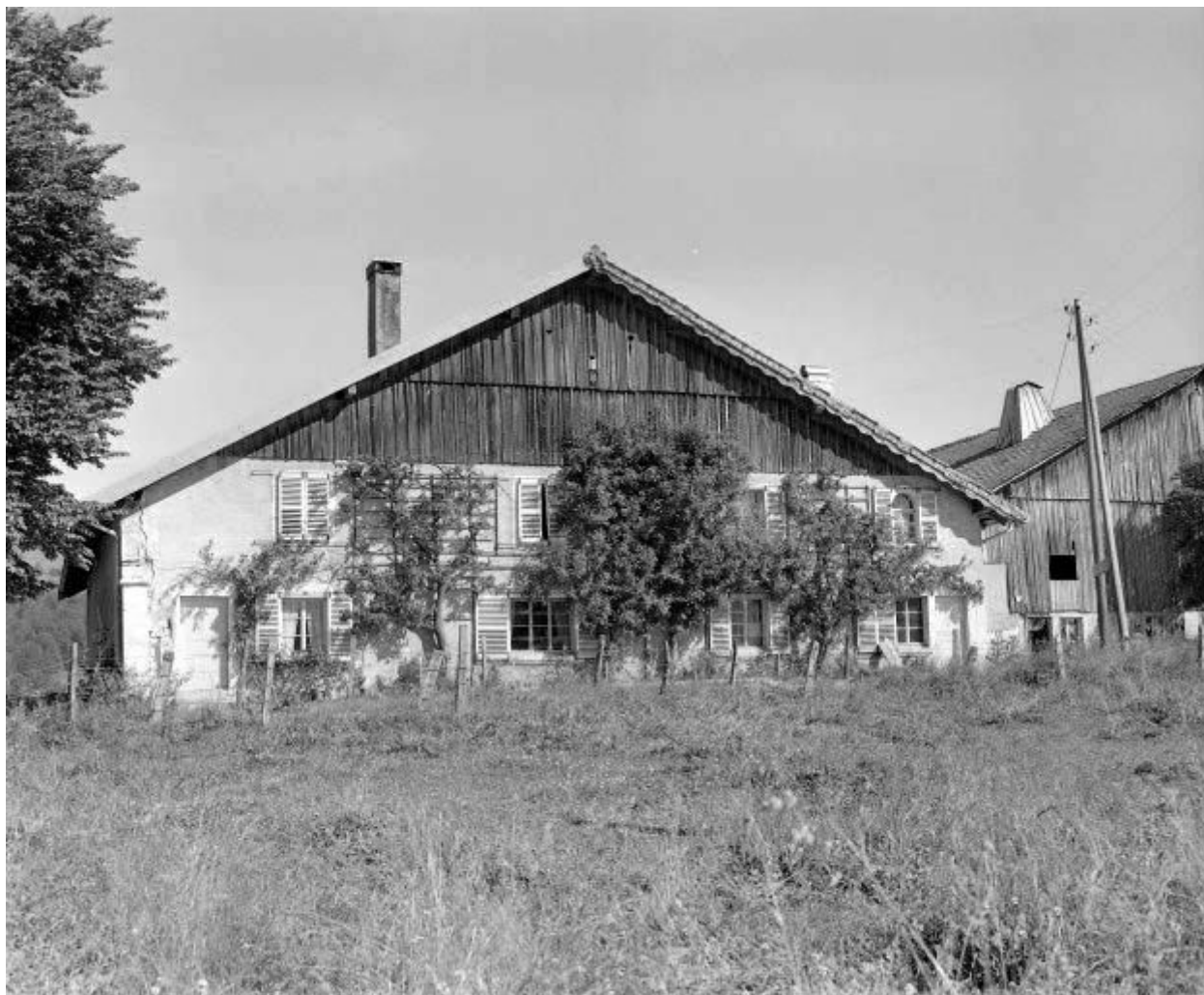
Ferme située à Bugny.
