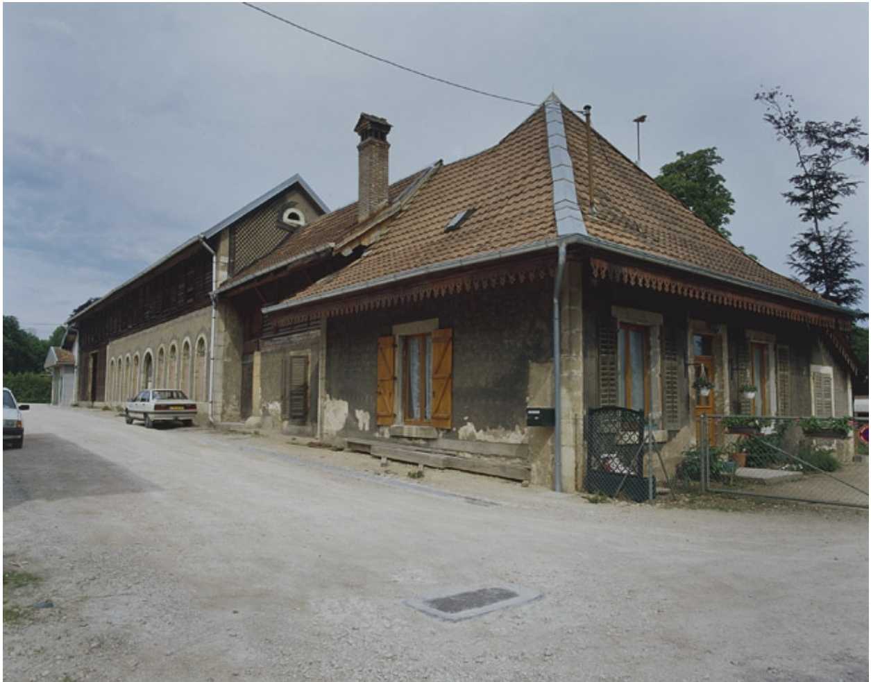
Orangerie et logement depuis l'est.
