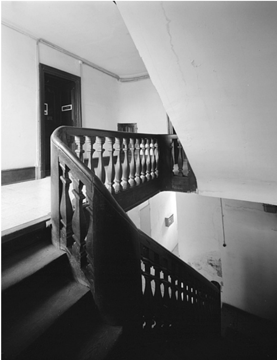
Escalier et palier du premier étage.
