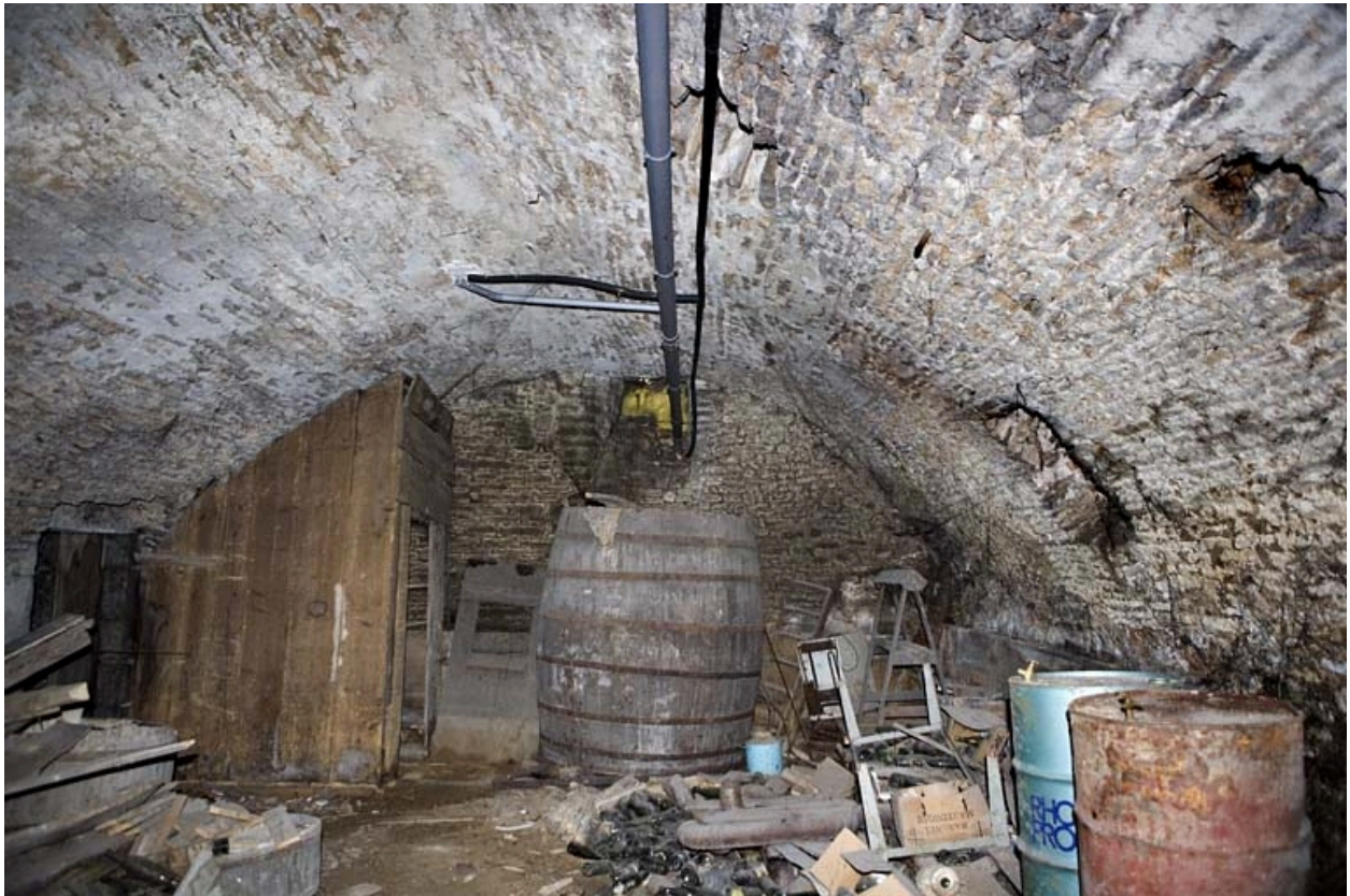
Intérieur, sous-sol : vue de la cave gauche, avec la réserve à bouteilles
