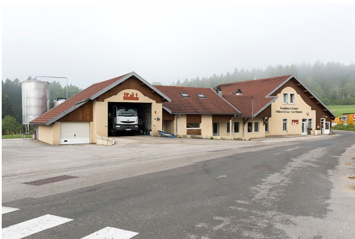
Vue d'ensemble, depuis l'est (façade antérieure).
