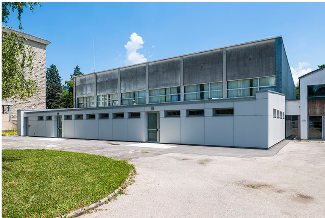
Façade antérieure du gymnase.
