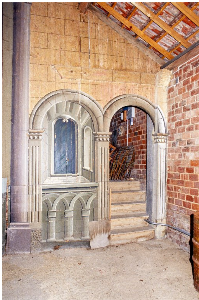
Baie côté cour, en 2002.
