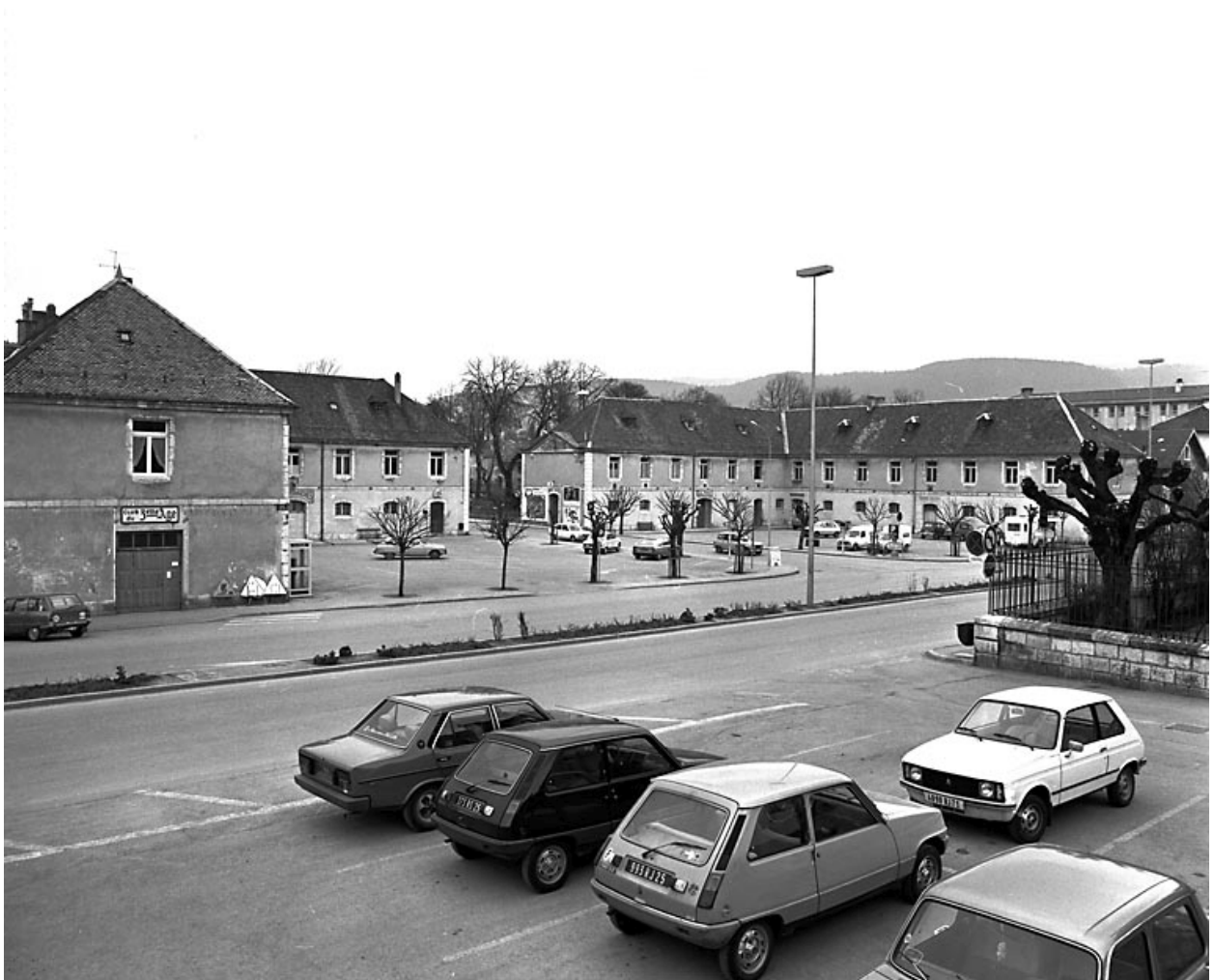
Caserne située place du Général Marguet.
