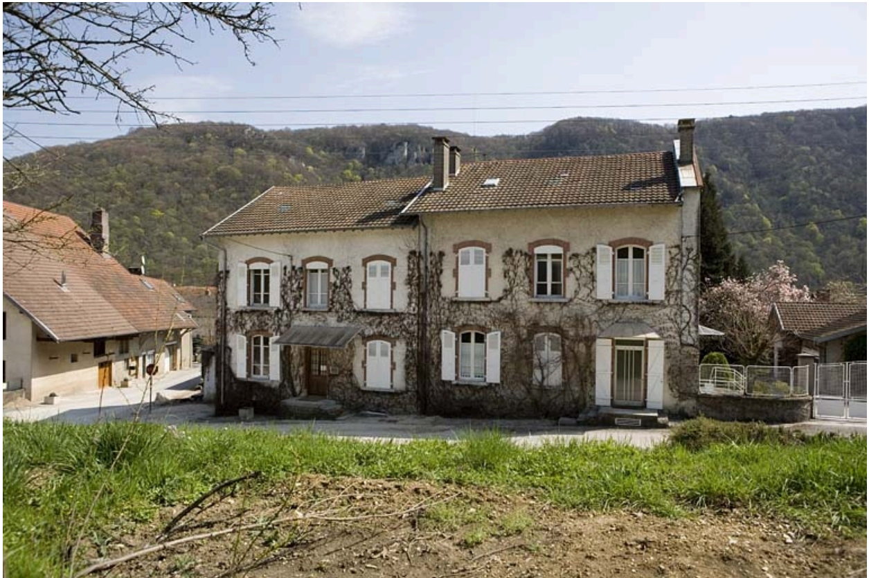
Logement patronal. Vue de la façade arrière.
