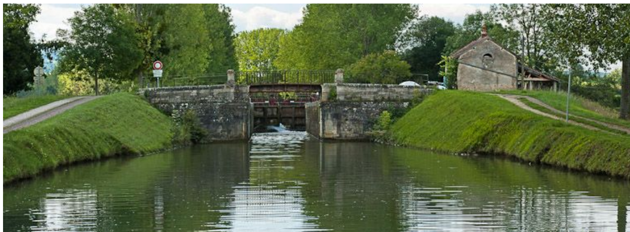
Vue du pont depuis l'aval.
