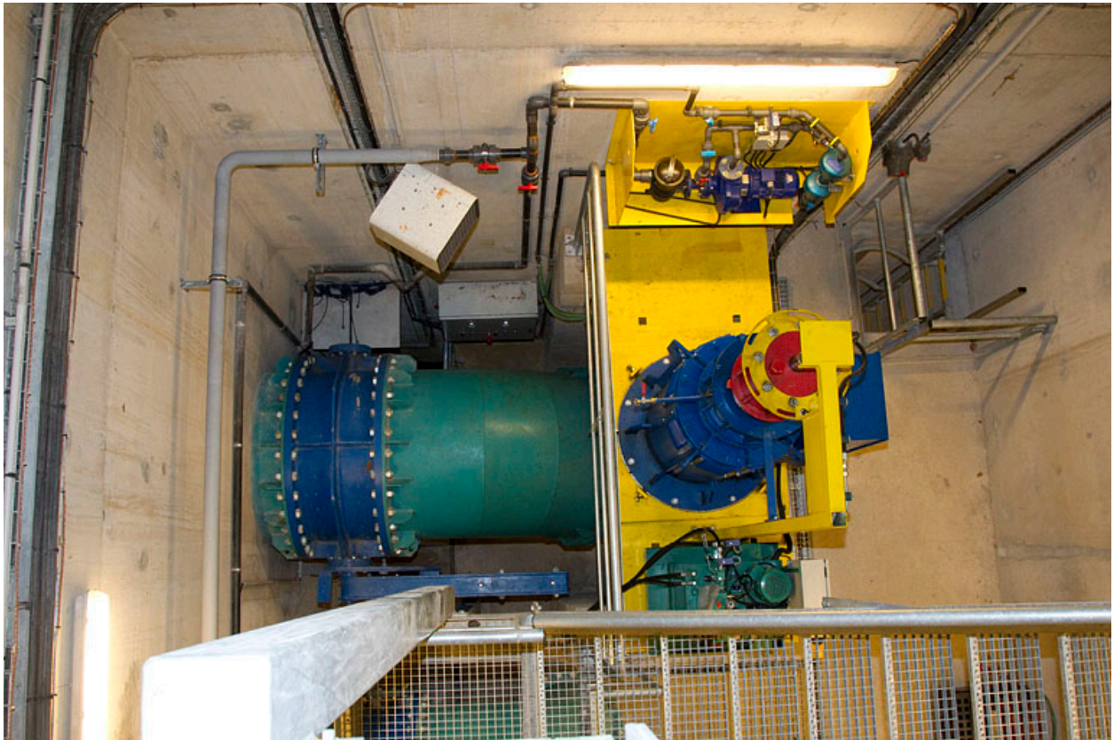
Barrage : vue plongeante sur le groupe de restitution.
