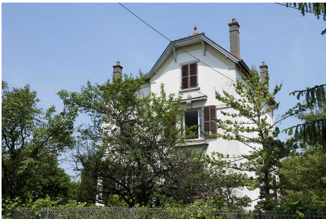
Etage supérieure d'une maison.
