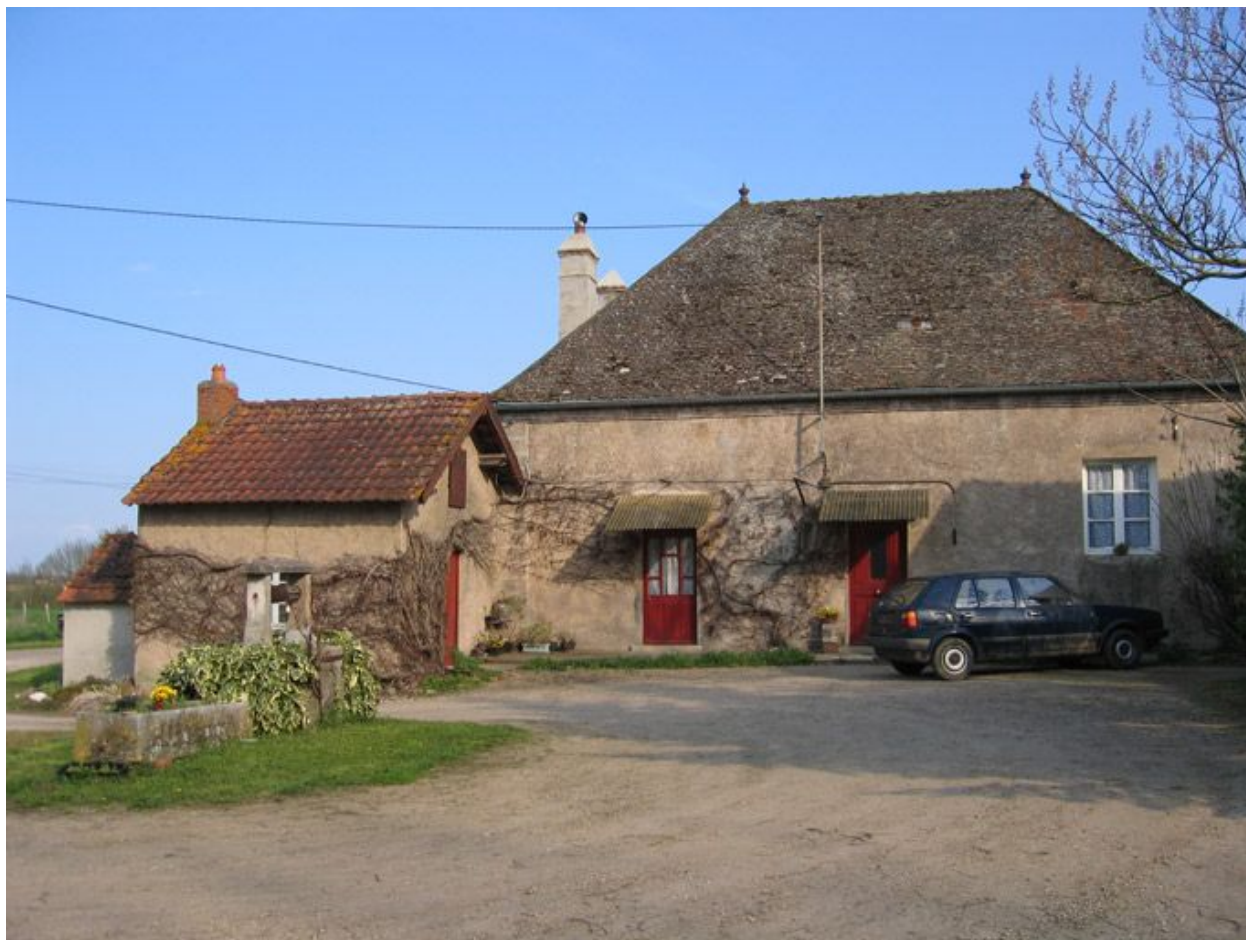
Vue d'ensemble de la façade de l'habitation.
