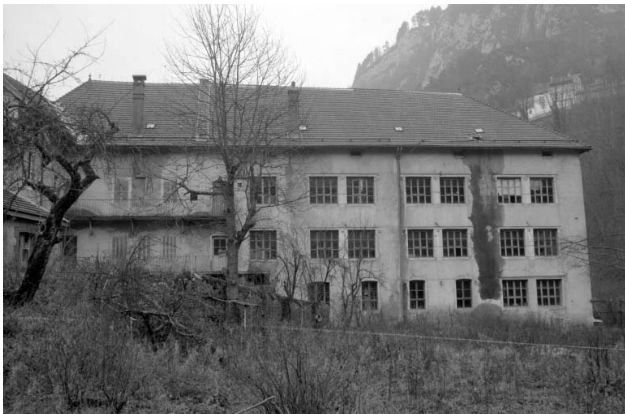
Façade postérieure de l'atelier de fabrication.
