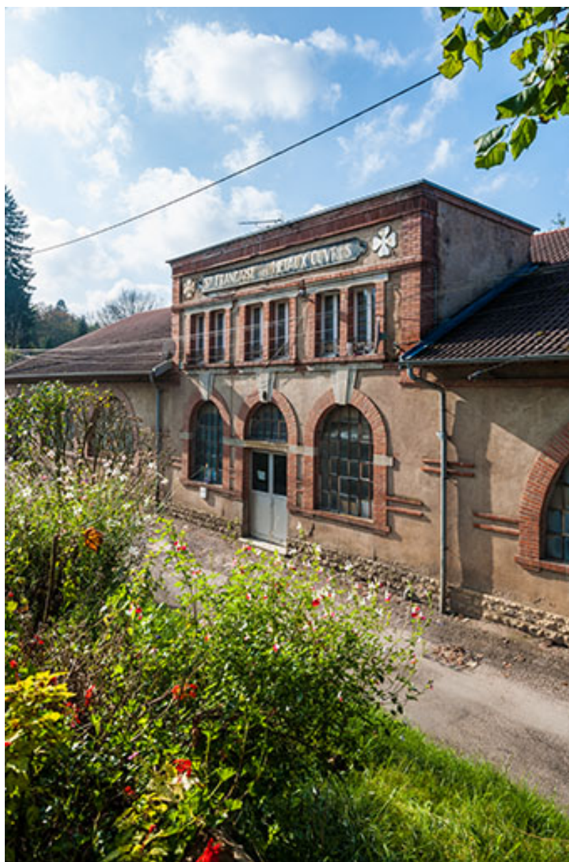
Travée centrale de l'atelier.
