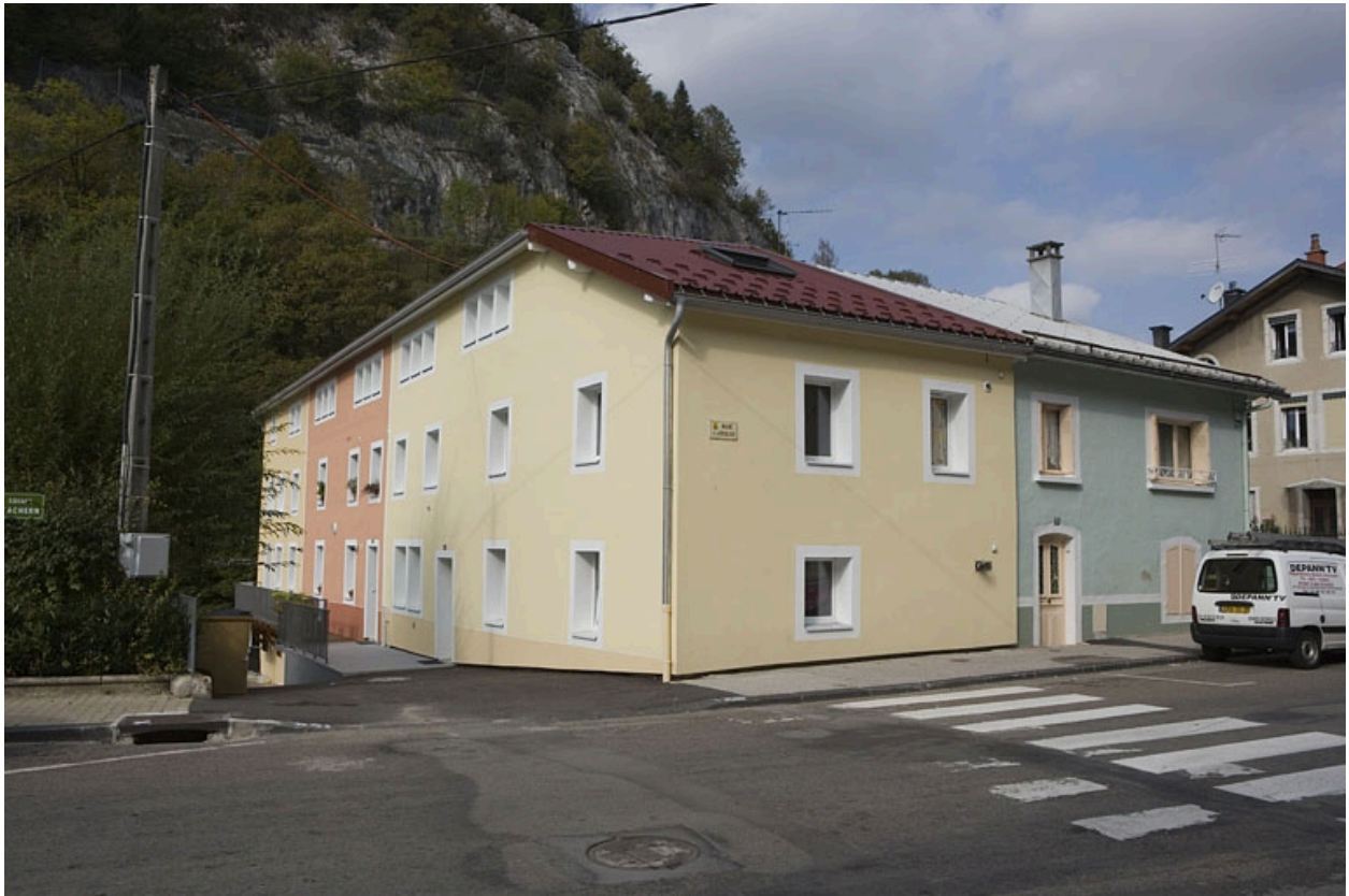
Vue de trois quarts, après restauration.
