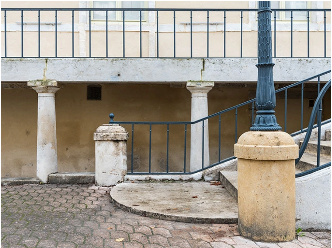
Aile nord, façade antérieure : départ de l'escalier et colonnes doriques supportant le balcon.
