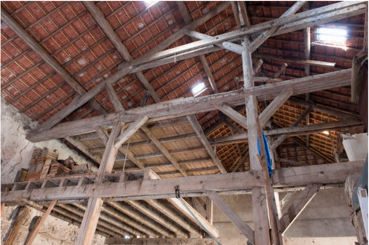
Grange : vue de la charpente et du pont roulant.
