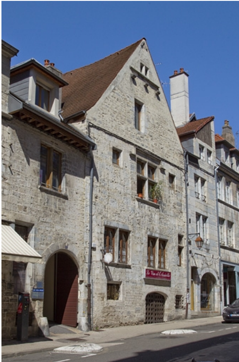
Maison : vue d'ensemble de trois quarts gauche.
