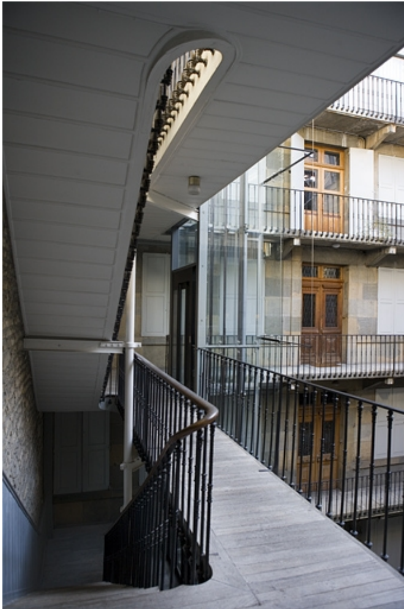
Détail de l'escalier à cage ouverte depuis l'un des paliers.
