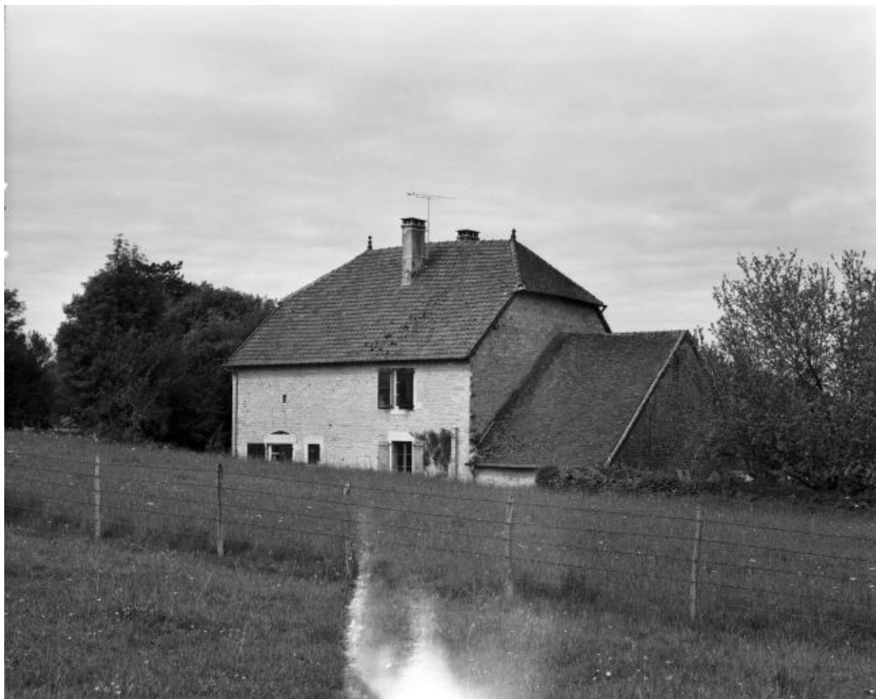
Ferme située chemin de la Muyre : vue d'ensemble.
