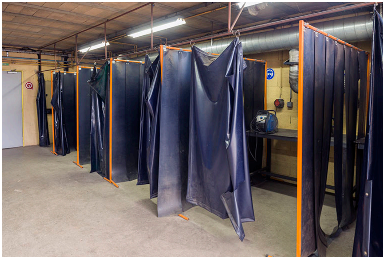
Postes de soudure.
