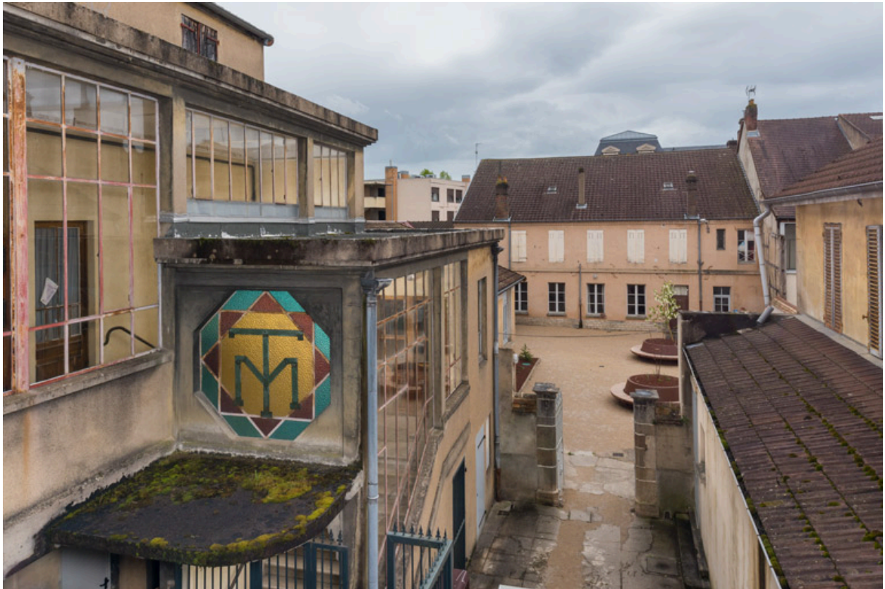
Cage de l'escalier principal (dépendance est) à gauche et loges d'acteur à droite, depuis la galerie vitrée.
