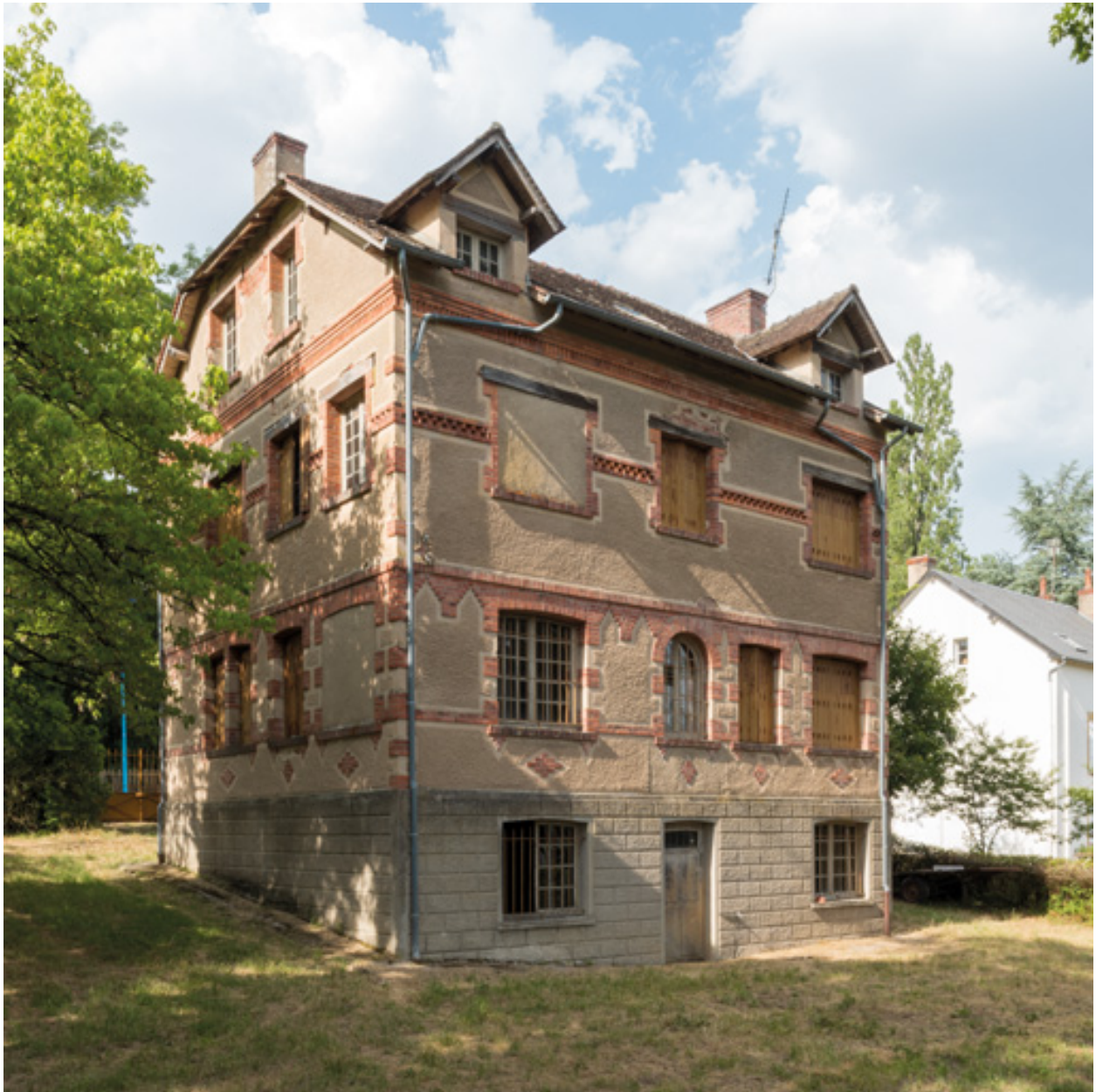
Façade postérieure, vue depuis le sud-ouest.
